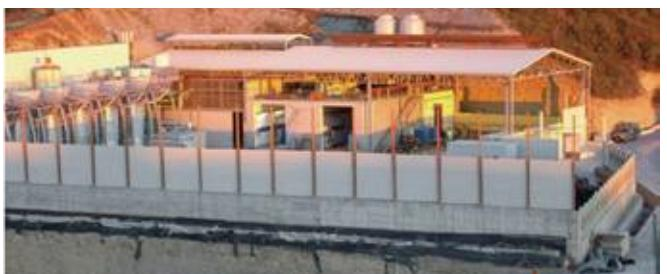
为意大利 Project Energy Srl 公司设计建造的轮胎裂解油电站 2X1MW 配备 G6300ZD 胎油发电机组
