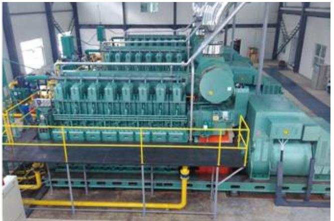
位于菲律宾的Pacerm-1重油电站3X3.5MW 配备DN8340ZD重油发电机组
