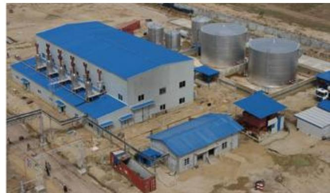
位于乍得的阿赫水泥厂自用重油电站 5X2MW GN8320ZD 重油机组
